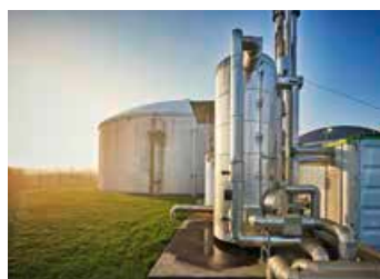
Oben: Thomas Fritsch bildet gemeinsam mit Anja Köhler-Damm die Geschäftsführung der BALANCE VNG Bioenergie GmbH. Unten: Eine Biogasanlage in Oschatz.
